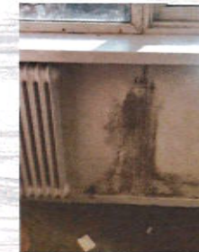
Oppervlakte condensatie muur
