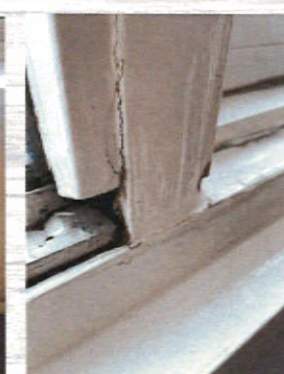
Schimmel (oppervlakte condensatie)
