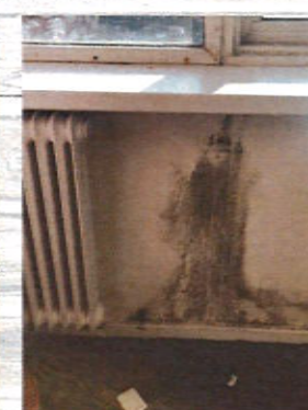
Schimmel (oppervlakte condensatie)
