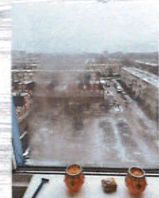
Oppervlakte condensatie raam
