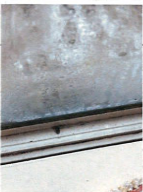
Veel enkel glas met oppervlakte condensatie (sommige woningen — hebben gaatjes in profiel)
